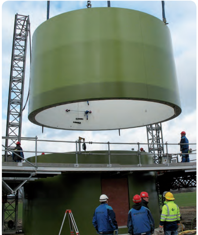
Montage von Windkraftanlagen
