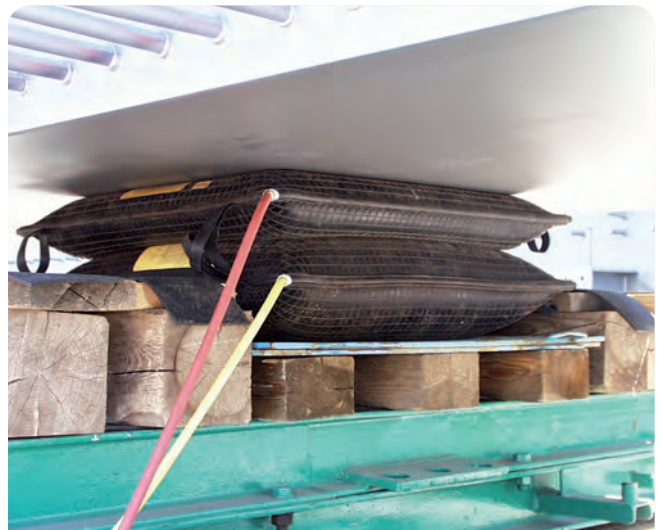
Unterbau von Brückenelementen
